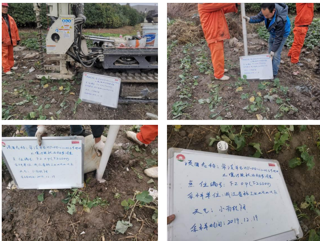
图 6-4 建井现场工作照片
